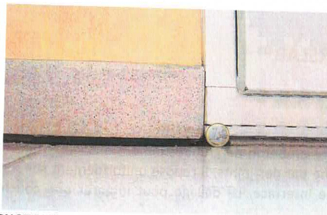
PHOTO N°6 : Tassement en périphérie d'un dallage pavillonnaire
