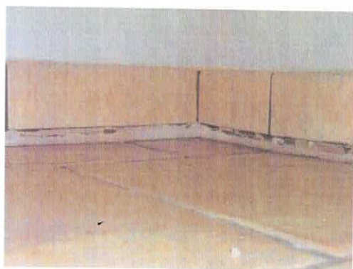
PHOTO N°8 : Avant injection sous dallage
