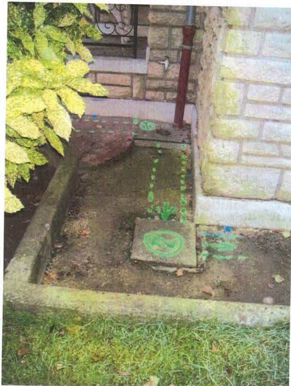
PHOTO N°2 : Détection des canalisations, matérialisation in-situ
